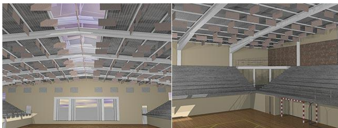
Figura 6.5– Exemplo n.º 1, da aplicação dos materiais absorventes suspensos. Interior do Pavilhão do Sport Clube Guimarães. Foto retirada ( http://projetos.prestige.com.pt/index )
