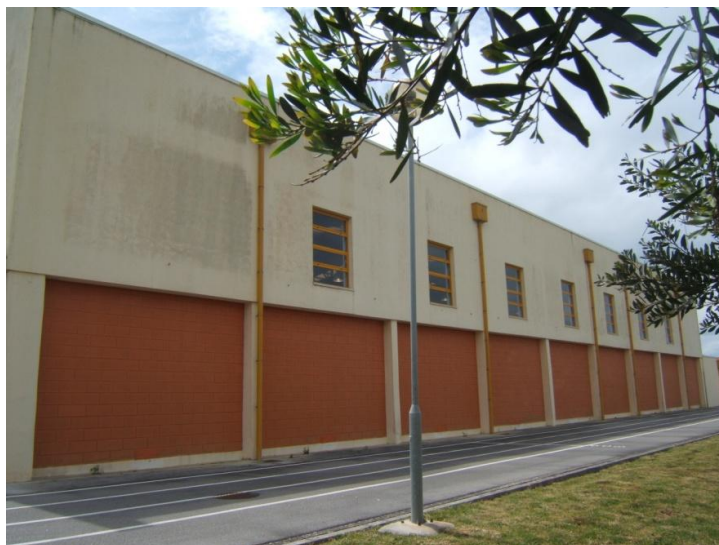
Figura 2.16 – Exterior da Escola Básica Integrada/JI da Torreira (Escola n.º 26). [Fotografia da autora]
