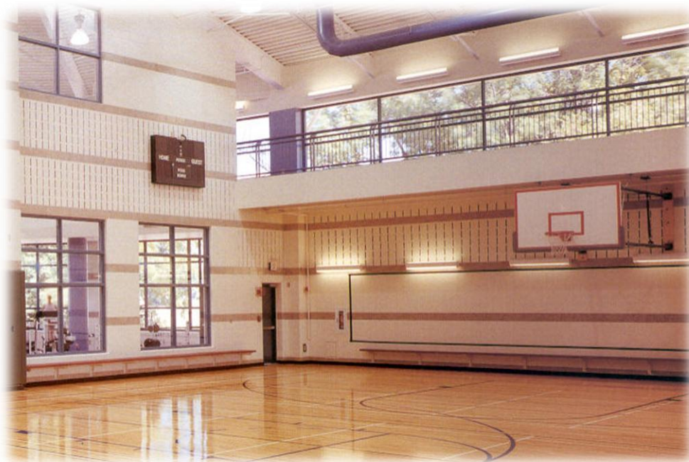
Figura 6.3 - Pavilhão de Dublin Community Recreation Center em Ohio munido de ressoadores agrupados (em blocos furados).
