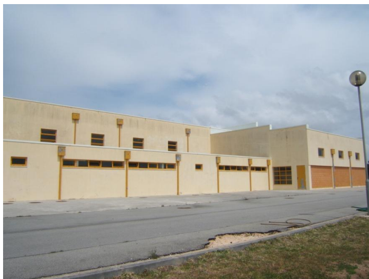
Figura 2.15 – Exterior da Escola Básica Integrada/JI da Torreira (Escola n.º 26). [Fotografia da autora]
